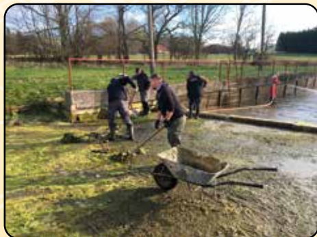
Čištění požární nádrže
