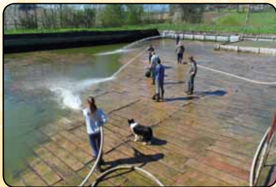
Čištění požární nádrže
