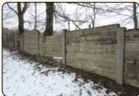
Hřbitovní zeď - starý stav
