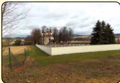
Hřbitovní zeď - nový stav
