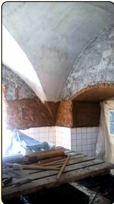
Moštárna - v době oprav
