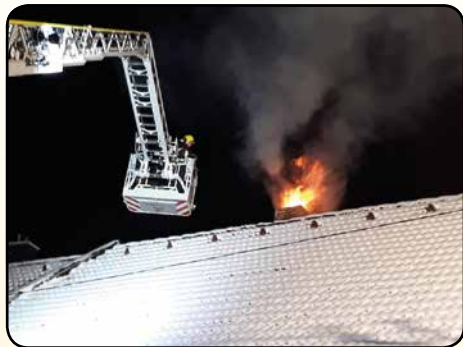
Požár komínového tělesa Plánice
