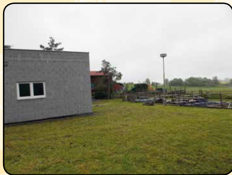
Stará ČOV po obnově
